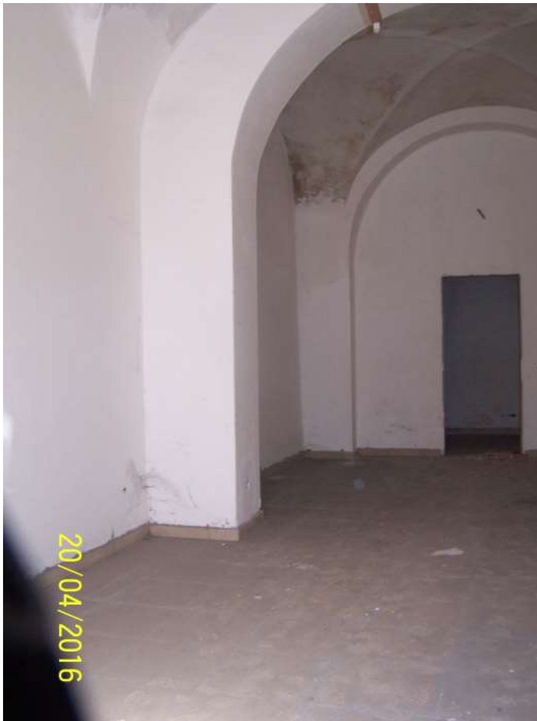
FOTO n° 11: Vista interna. Locale principale (composto da due vani).
