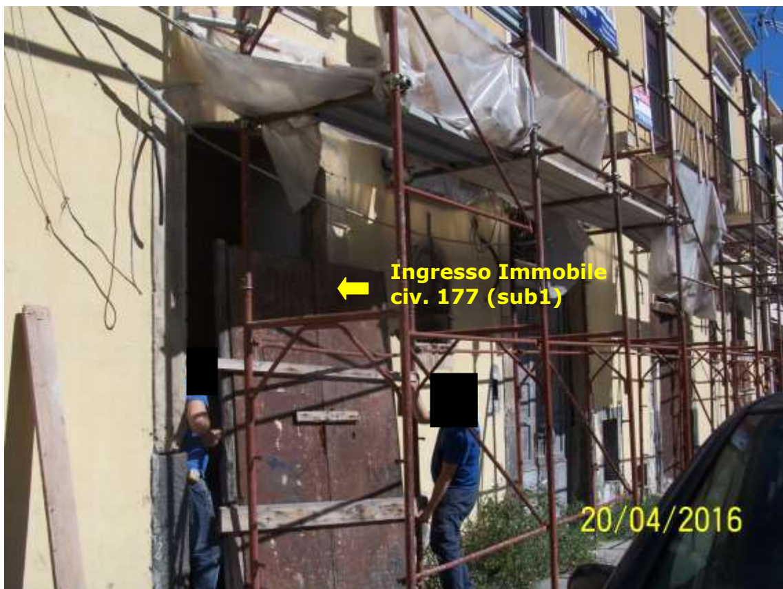
FOTO n° 3: Vista esterna. Ingresso immobile.
