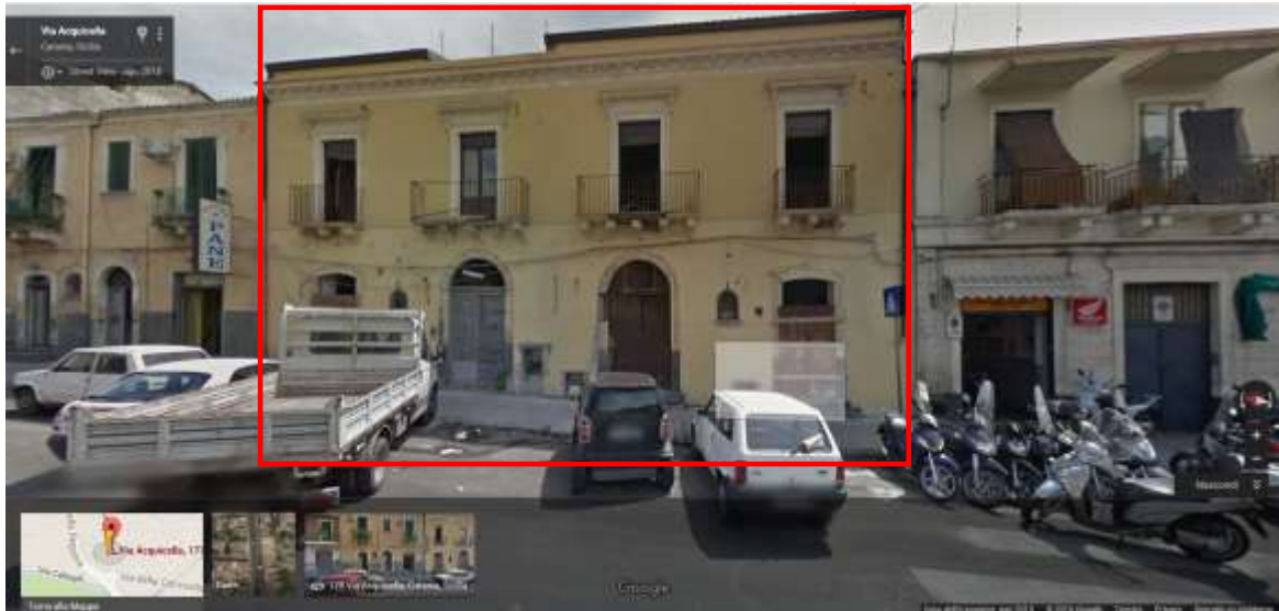
FOTO n° 4-5: Vista esterna – individuazione globale dell’edificio a cui appartiene l’immobile (vedi riquadro in rosso) - Prospetto su via Acquicella – Acquisizione da Google Maps.
